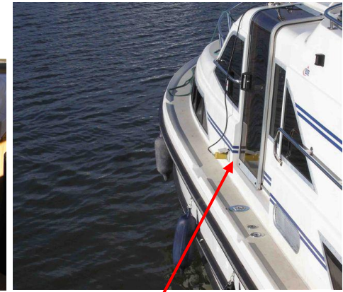
Prise extérieure Switchboard for shore power Instrumententafel für Landstromanschluss
